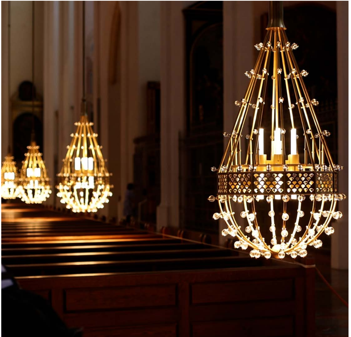
Abbildung 4: Leselicht, Raumlicht, Gewölblicht: Jeder Kronleuchter ist technisch in drei Lichtebenen aufgeteilt. Foto: STGLicht
