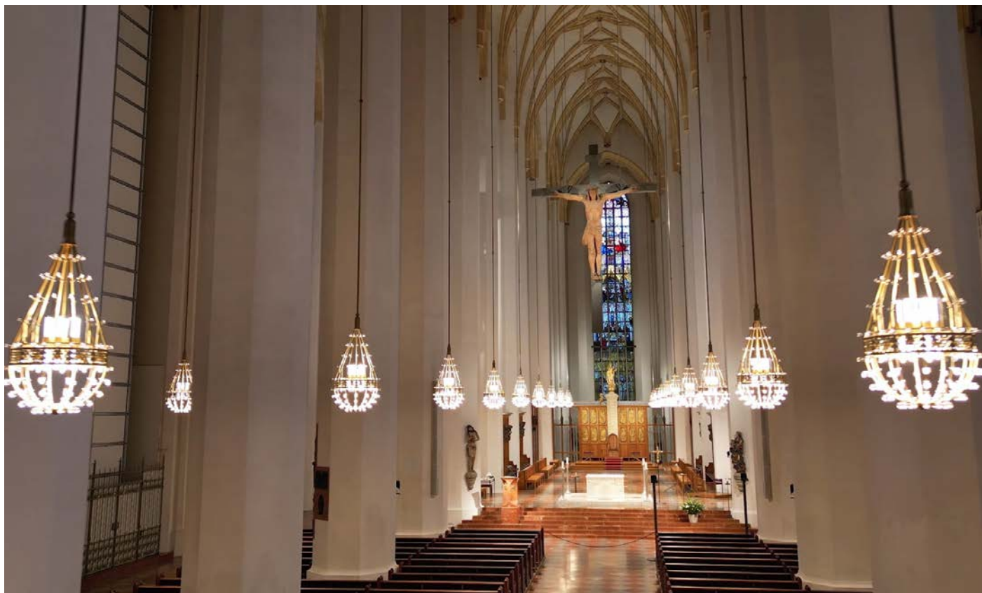
Abbildung 2: Eine Herausforderung bezog sich auf die Raumhöhe der Kirche: Auch das Gewölbe in 35 Metern Höhe sollte durch die Kronleuchter beleuchtet werden. Foto: STGLicht
