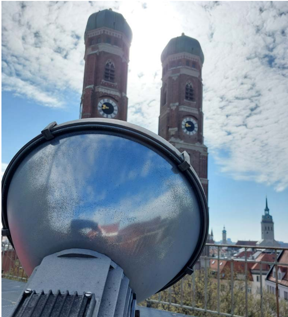
Abbildung 7: Die alte Beleuchtung bestand aus insgesamt 18 Scheinwerfern. Diese hatten jeweils eine Leistung von bis zu 600 Watt. Foto: Baureferat der Landeshauptstadt München
