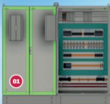
01 Die Kabelkonfektionierung erfolgt vollautomatisch
